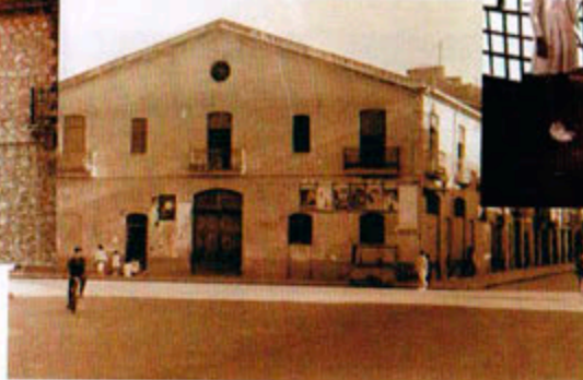
Almacén de Masip
